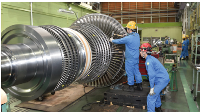
蒸気タービンロータの翼植え作業の様子
