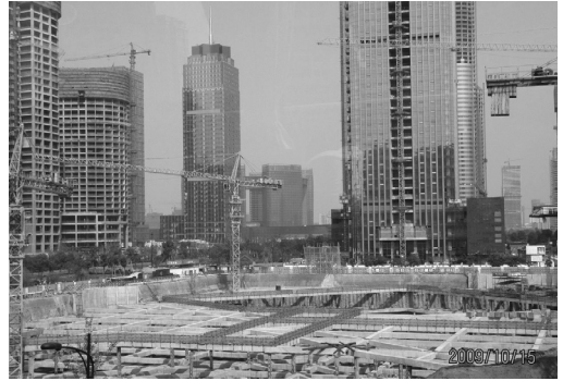
急ピッチで進む杭州新市街の開発
