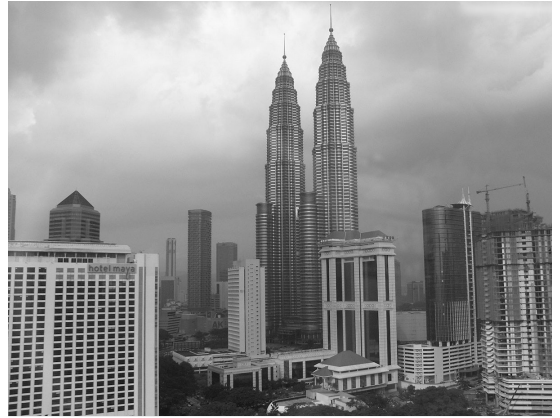
クアラルンプール市内ルネッサンスツインタワービル
