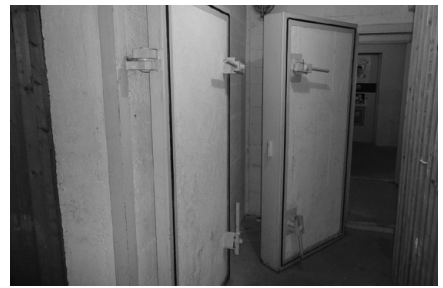
写真②: シェルターのドアは、厚い鉄製。また部屋は重厚な鉄筋コンクリートの壁に覆われている。
