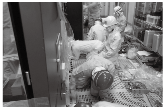
生産設備の復旧作業
