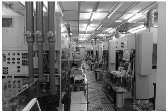
支援部隊の努力で復旧したクリーンルーム
