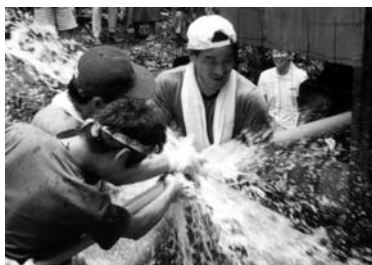
「サラワク」水道管から水がふれだす
