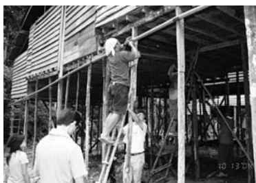
「サラワク」配管作業
