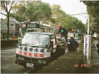
給水車での給水作業の手伝いをする鉄鋼労連のボランティア
