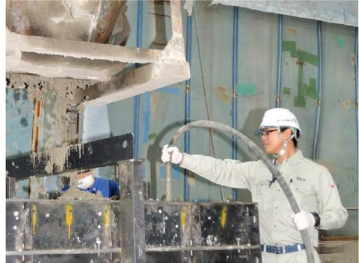
型枠内に流し込んだコンクリートを攪拌する作業員
