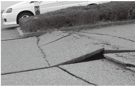
② 工場道路の亀裂
