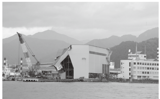
②津波により被災した全天候バス
