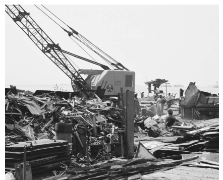
④安全な作業場・通路は見当たらない。
