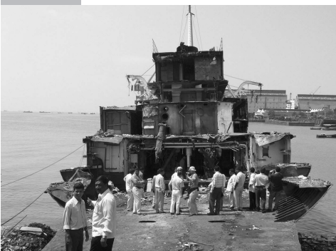
①「ビーチング方式(浜解撤)」によって解体される廃船。
