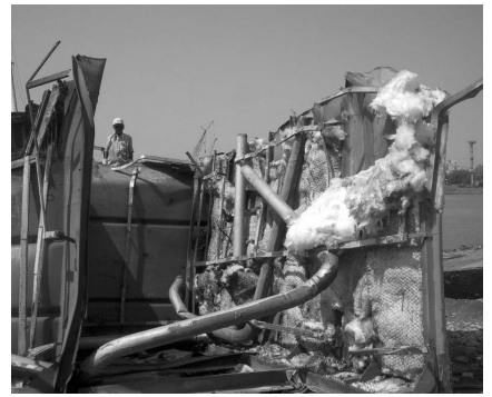
②アスベストらしきものがむき出し状態のまま放置されていた。
