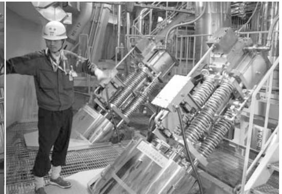
主蒸気をタービン建屋と謝絶する「主蒸気隔離弁」
