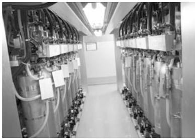
制御棒を緊急挿入する装置
