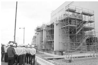
変圧器の火災で焼けこげた3号機の防火壁
