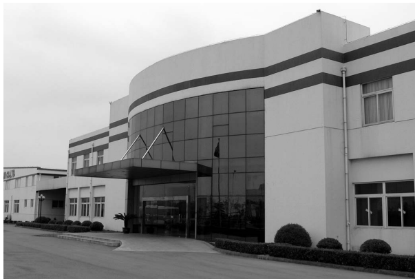
上海の日系電機企業外観
