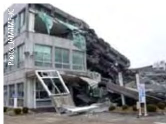
Photo: JAM/IMF-C 地震で被害を受けた JAM の施設
